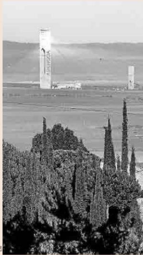
Planta termosolar de Abengoa en Sanlúcar la Mayor.
